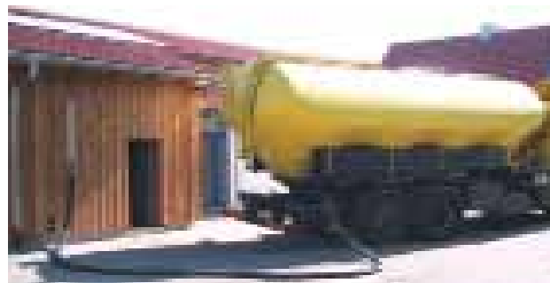
La livraison du granulé dans le silo de stockage se fait rapidement grâce à un camion souffleur
